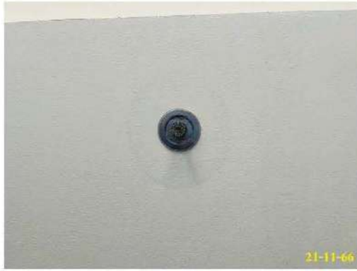
ระบบหัวกระจายน้ำดับเพลิงอัตโนมัติ
